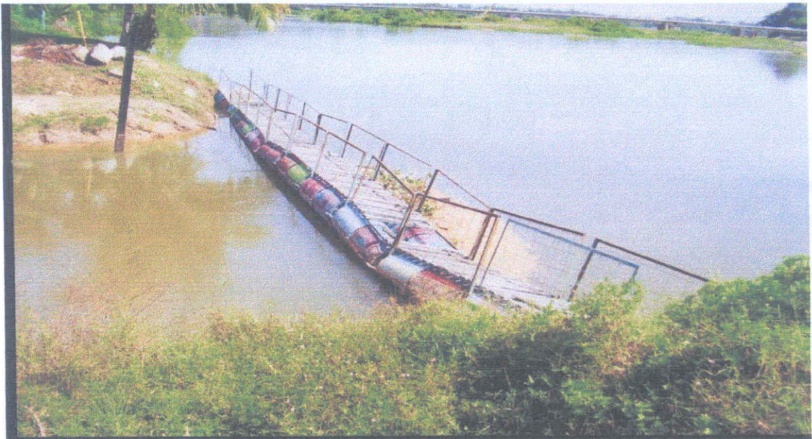
Pontoon yang digunakan sebelum inovasi (hampir tenggelam)
