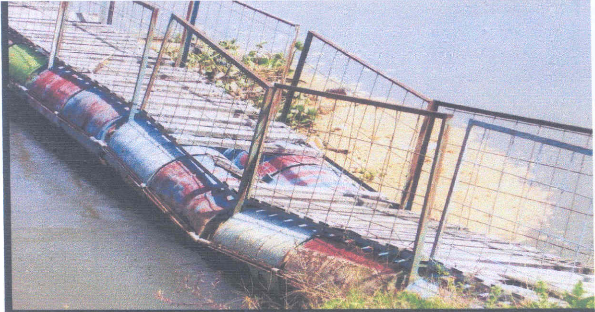
Pontoon yang digunakan sebelum inovasi (hampir tenggelam)
