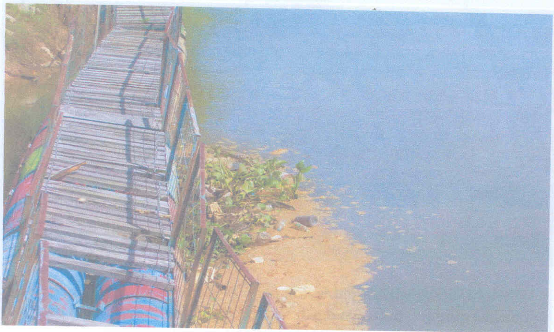
PONTOON JERANGKAP YANG BOCOR DAN HAMPIR TENGSELAM
