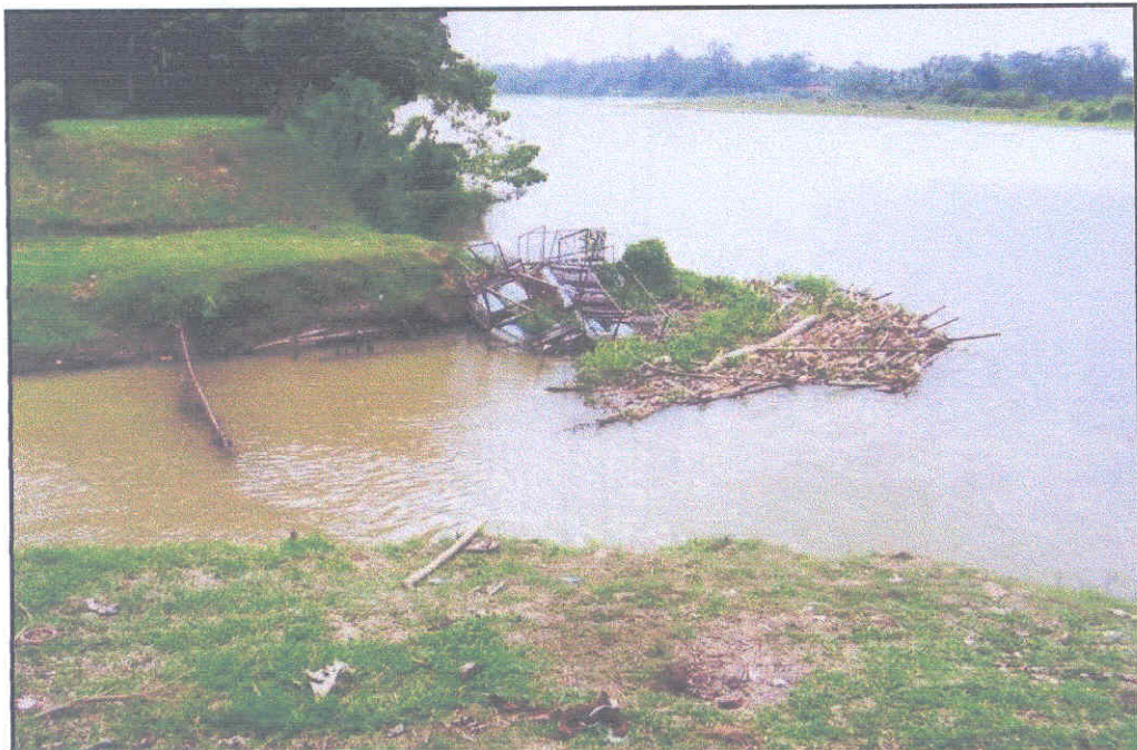
Pontoon jerangkap sampah (drum) yang bocor dan tenggelam
