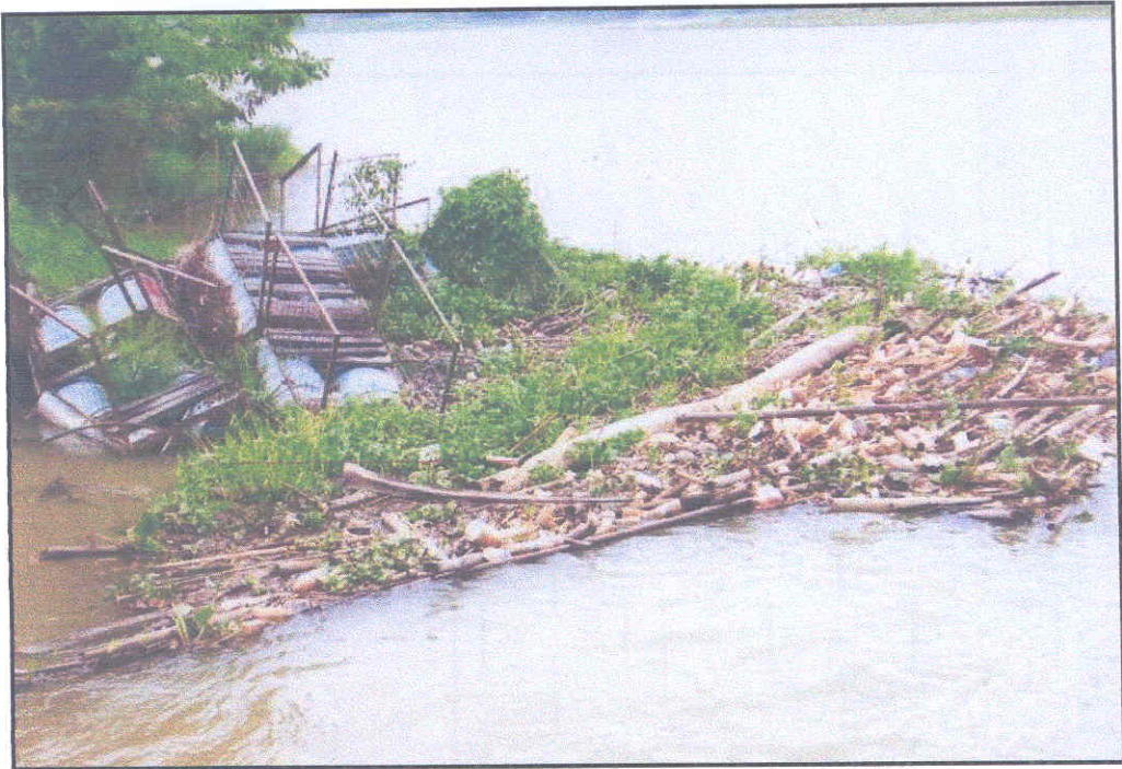
Pontoon jerangkap sampah (drum) yang bocor dan tenggelam
