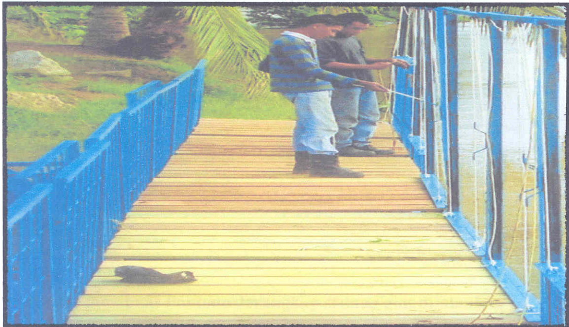
Papan tanalised 9" x 1" untuk lantai laluan
